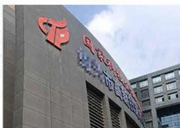
铝塑板外墙翻新
